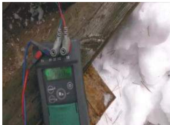
Рис.2. Замер сопротивления заземления существующего устройства
