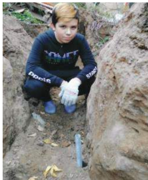
Рис.4. Трениея под заземление
