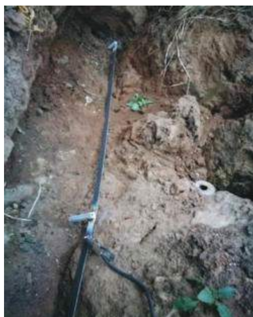
Рис.4. Трениея под заземление
