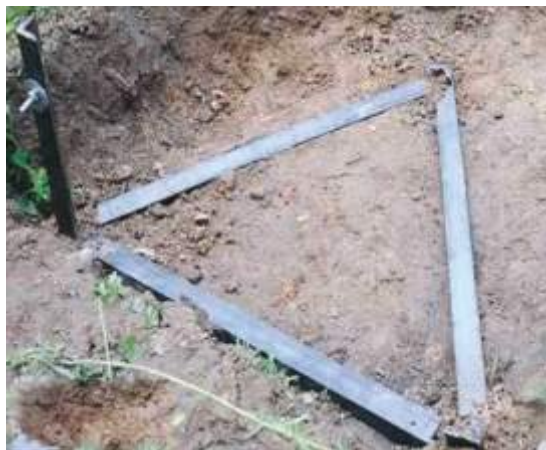
Рис.1. Контур заземления.
