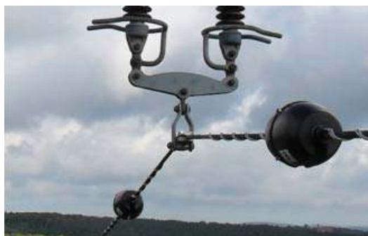
Рисунок 1. Системы контроля обледенений с помощью датчиков усилий: а - СТГН; б - ASTROSE.
